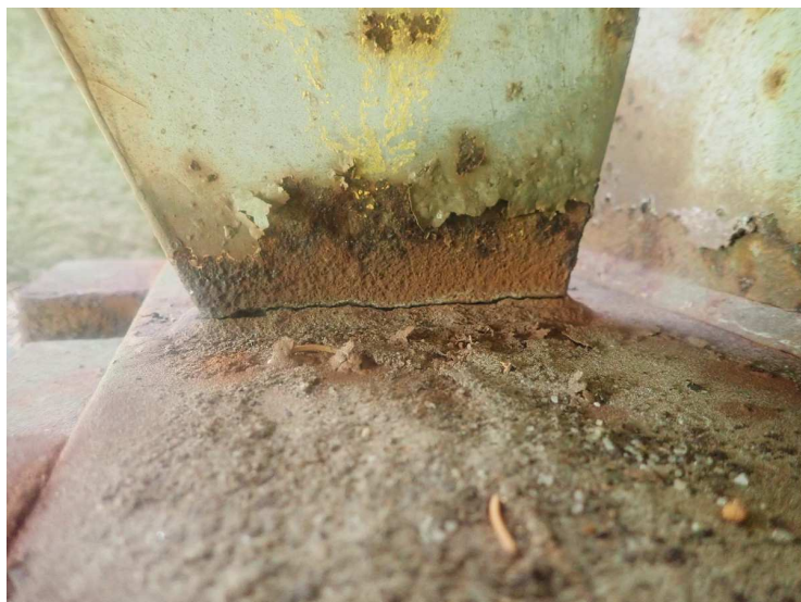
Foto č. 1 Konstrukce K 01 – nad O 01 vlevo – trhlina ve svaru na svislé výztuze
