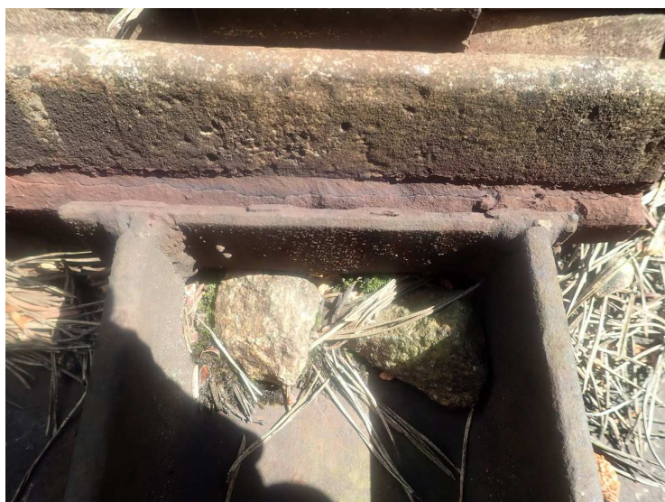
Foto č. 6 Železniční svršek – přímé upevnění č. 8 vpravo – trhlina ve svaru
