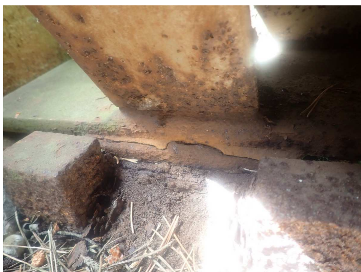
Foto č. 3 Konstrukce K 01 – nad O 02 vpravo – utržená horní ložisková deska
